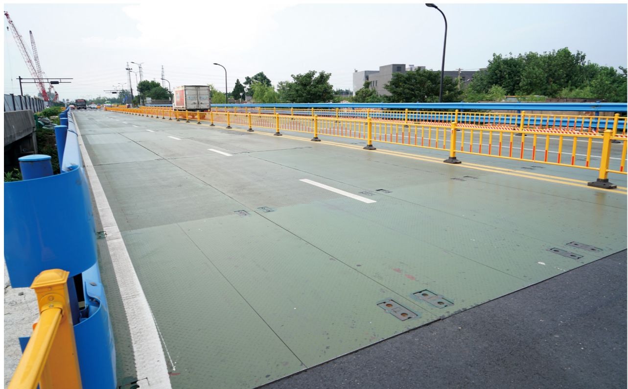
项目名称:杭州轨道交通9号线SG9—8标段
