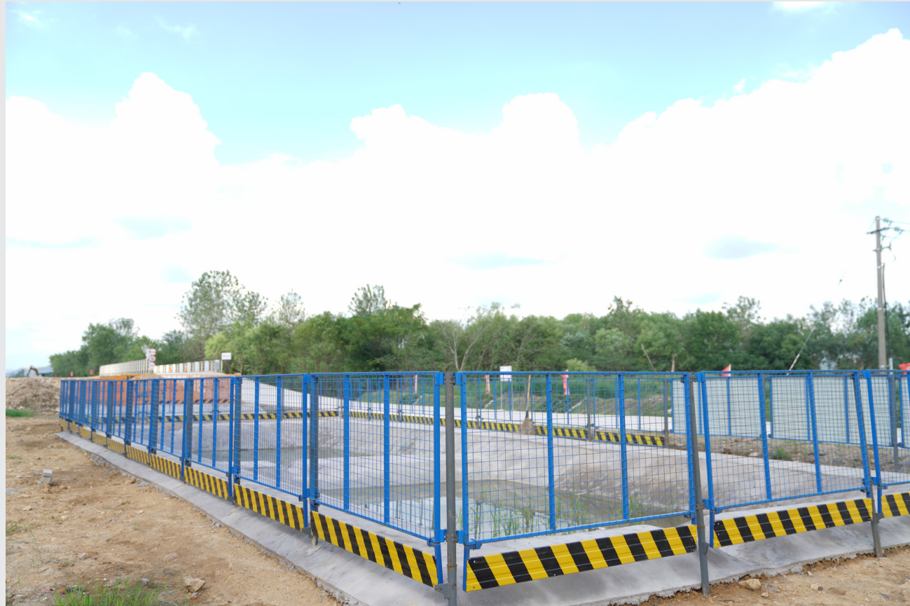
中铁三局沪苏湖铁路1标项目二分部
