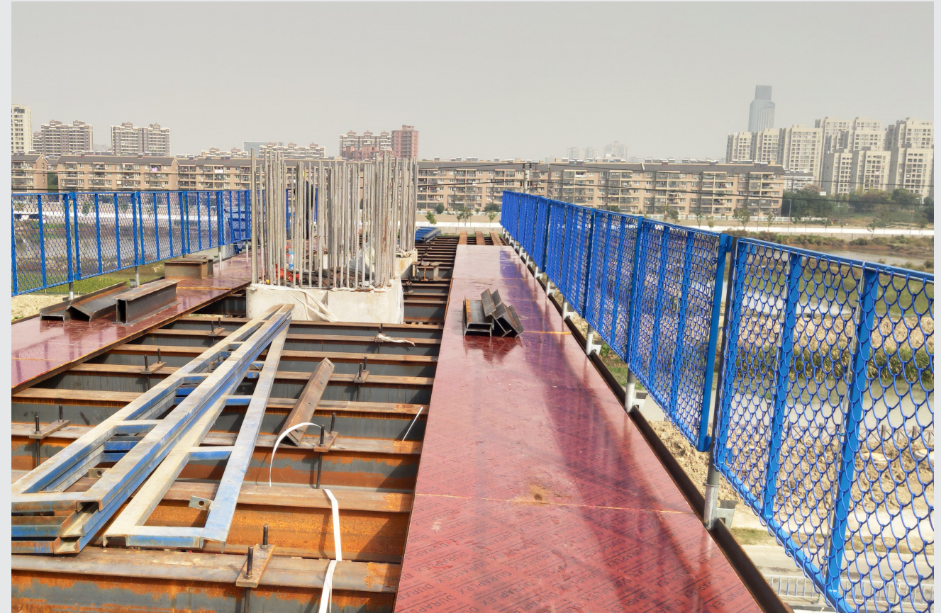
嘉兴市市区快速路环线工程(一期)土建二标
