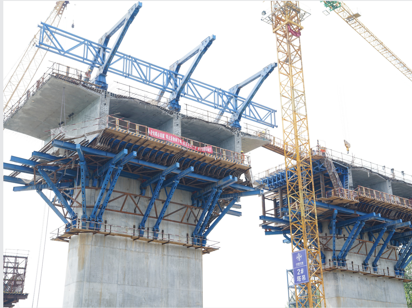
项目名称:中交第二公路工程局有限公司浦仪公路西段A2标项目
