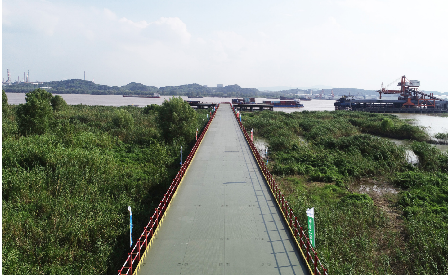
南京仙新路过江通道钢便桥工程
