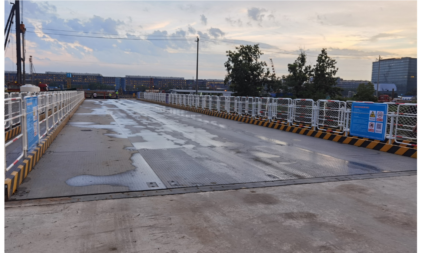
杭州阿里巴巴西溪项目钢便桥工程
