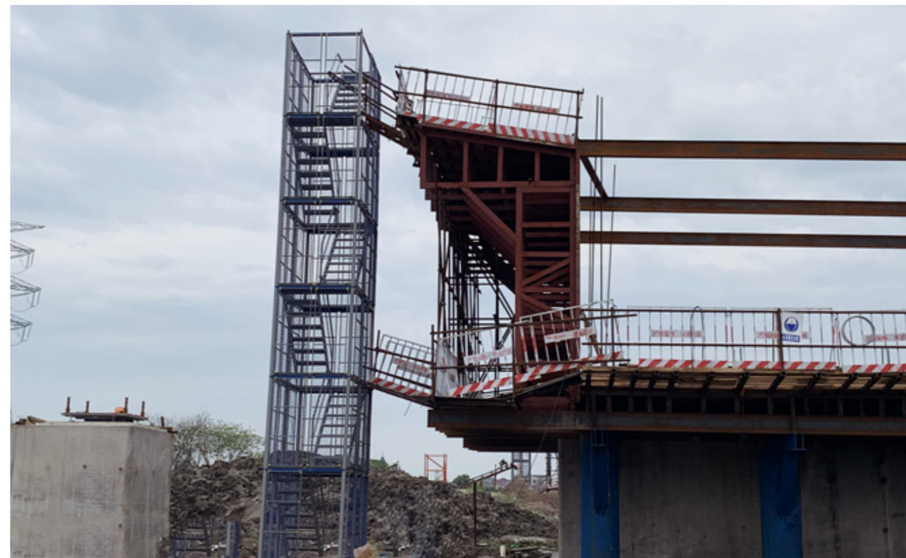
项目名称: 中交一公局京杭运河浙江段三级航道整治工程杭州段7标段
