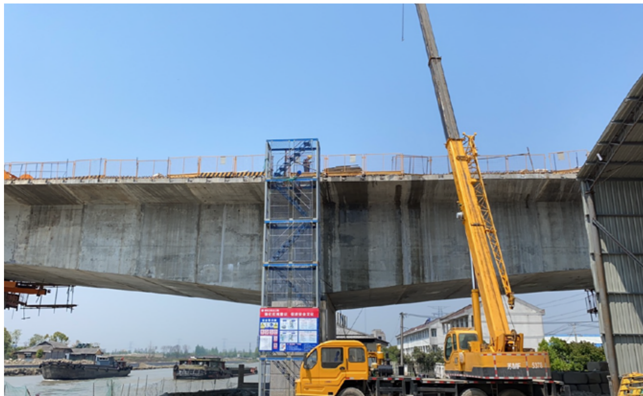
项目名称: 徐州市公路工程总公司乌镇太师桥改造项目
